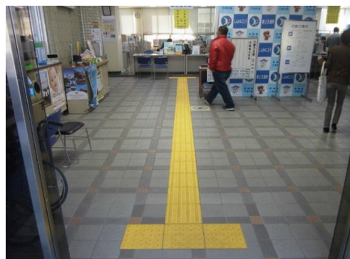
◎庁舎1階点字ブロック
