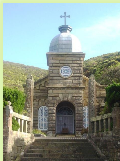
◎国指定重要文化財 頭ヶ島天主堂
